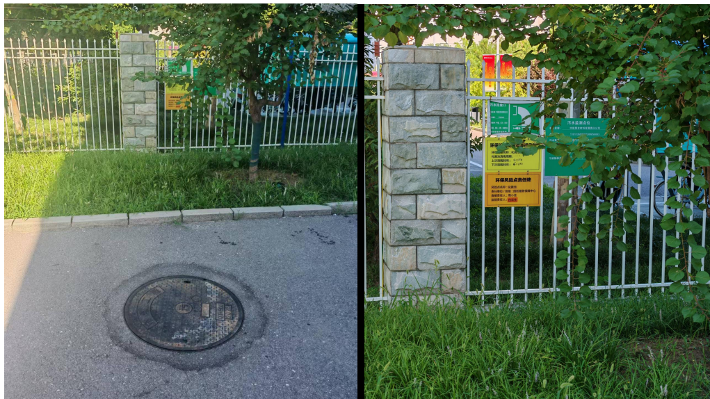
图 3-5 本项目污水总排口
